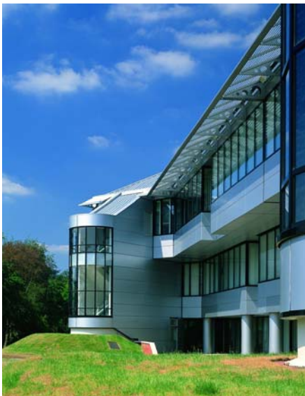
Figuur 1: De externe bekleding van dit openbare gebouw is gemaakt van PUR-sandwichpanelen met stalen oppervlakken en glas.
