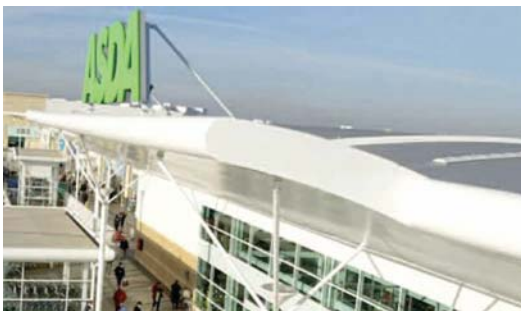
Figuur 5: Gebruik van PUR-sandwichpanelen met stalen oppervlak op een buitenmuur en als dakbedekking van een winkel [14].
