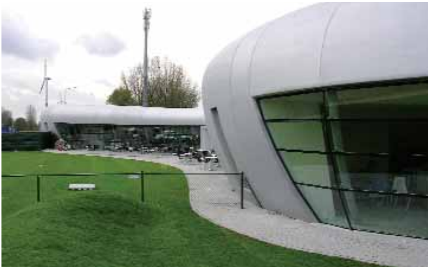
Achterzijde van het futuristisch ogende benzinestation dat Nedcam maakte van geprefabriceerde EPS-schuimblokken onder een polyurea-coating
